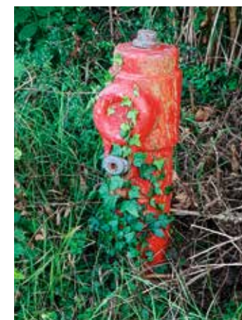
Der skal altså være ryddet rundt om brandhænder, også for at brandmandskab ikke ligefrem får brug for en metaldetektor for at finde dem. Foto: Jørn Bitsch.
