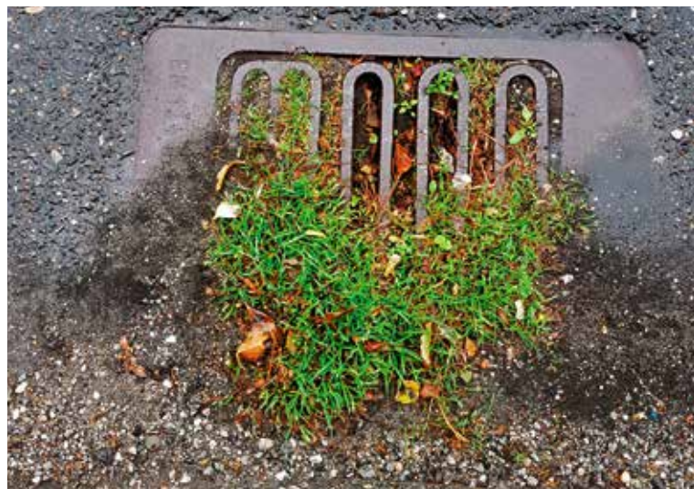
Foto ovenfor er blot et eksempel af utallige på en regnvandsbrønd, der bør oprenses, således at den kan opfylde sit formål, men i det mindste ligger rillerne den rette vej. Foto: Jørn Bitsch.
